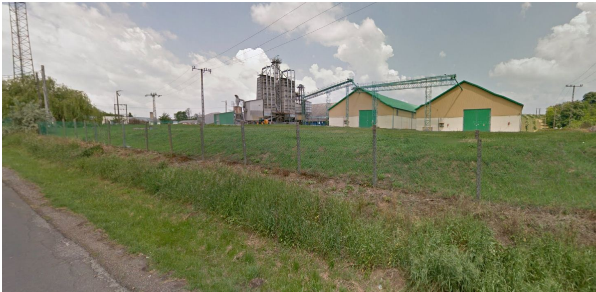
2. ábra: Nitrogénművek Zrt. hőgyési telephelye
